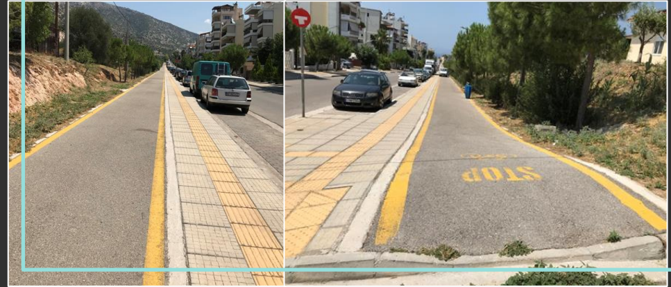
Επί της οδού Αγ. Νεκταρίου, 512.4 μ.
