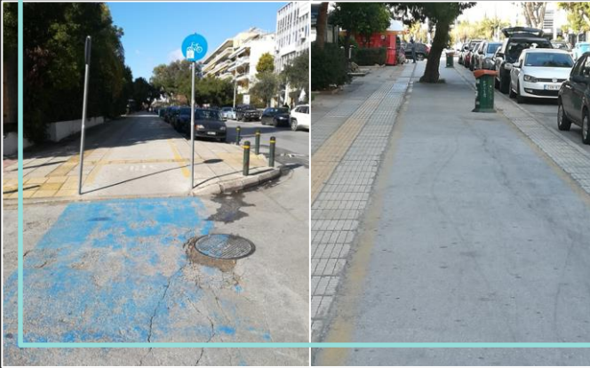
Επί της οδού Λαζαράκη, 259.2 μ.
